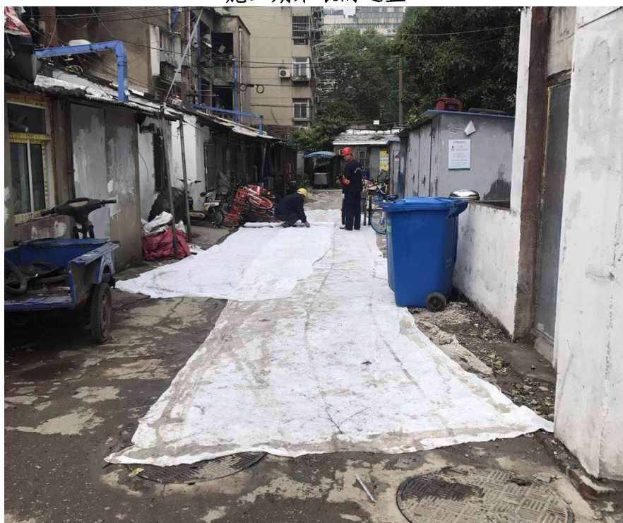
施工路面的遮盖
