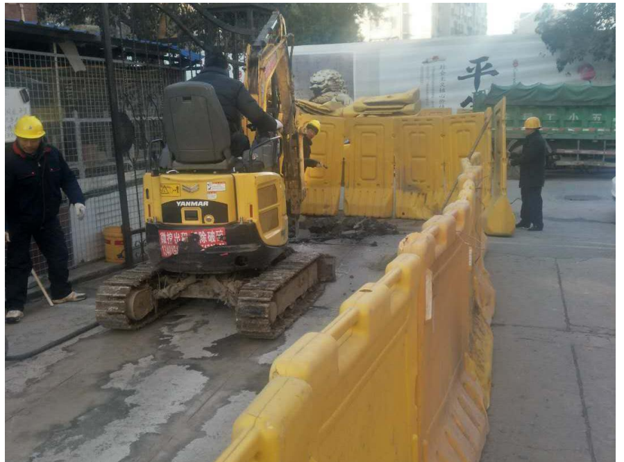
施工期采取的围挡
