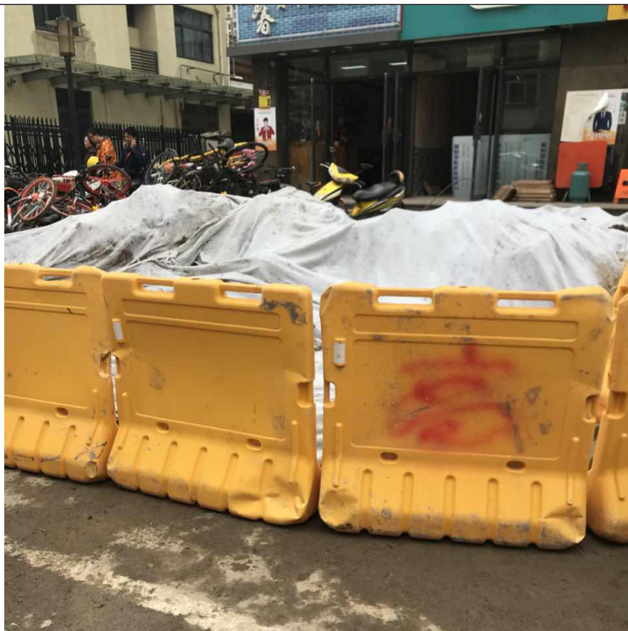
施工期采取的遮盖
