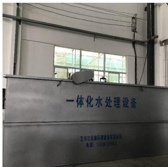
图 3-1 废水处理设施——一体化水处理设备
