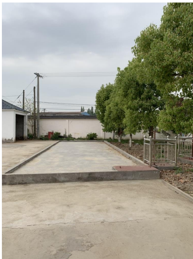
图 3-9 事故应急池照片
