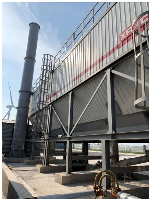
图 3-2 布袋除尘+二级碱液水喷淋装置照片
