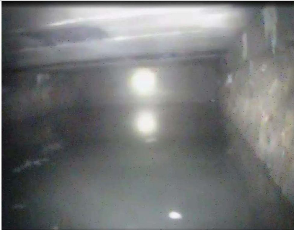
图 2-5 童子仓沟内部照片
